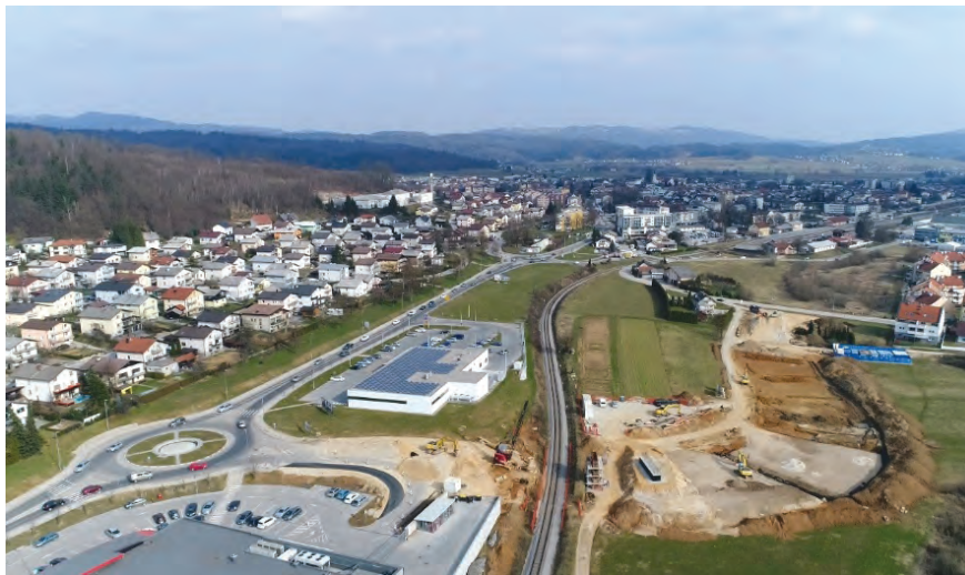
Pričela so se gradbena dela za nov nadvoz Brezje.
