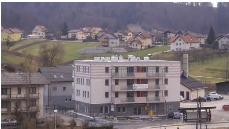
Novi poštne prostori v pritličju stanovanjskega bloka v Višnji Gori
