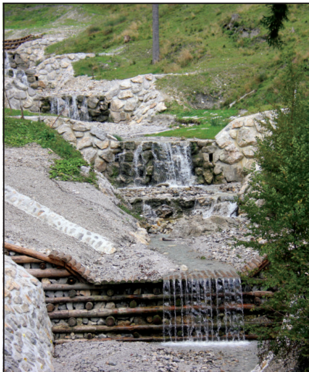
Bregovi pritoka v Klemenčevem, zavarovani s tradicionalnimi kranjskimi stenami (Foto: arhiv Občine Kamnik)
