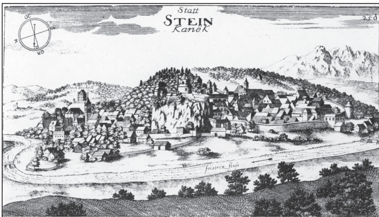
Valvasor je kot vzrok za razlitje kamniškega jezera navedel strahotno deževje, ki je z naraslo vodo predrlo naravno mejo med Malim in Starim gradom. Kamnik v Valvasorjevem času: levo je vidno predmestje Šutna, v sredini Mali grad z golim južnim pobočjem, desno mesto Kamnik. (J. W. Valvasor, Topografija 1995 [1679], bakrorez št. 250)
