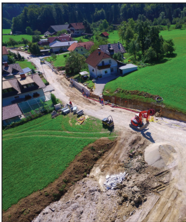
Ureditev kanalizacijske infrastrukture v Tunjicah (Foto: Žiga Deisinger)
