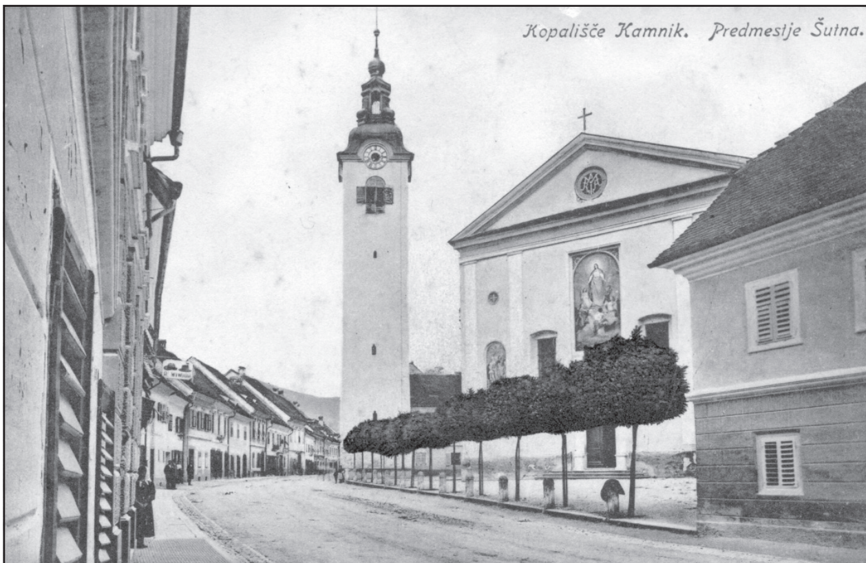
Zvonik cerkve Marijinega brezmadežnega spočetja na Šutni je zbujal pozornost tudi zaradi domnevnega ugrezjanja. Nova interpretacija predpostavlja, da je cokel zvonika zakrilo nasutje. Šutna pred letom 1908, dopisnica. (Zasebna last)
