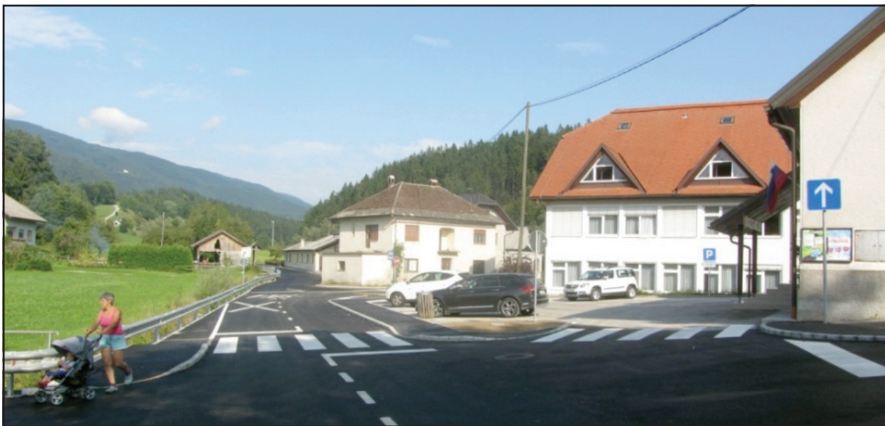
Rekonstrukcija ceste v Šmartnem v Tuhinju (Foto: arhiv Občine Kamnik)
