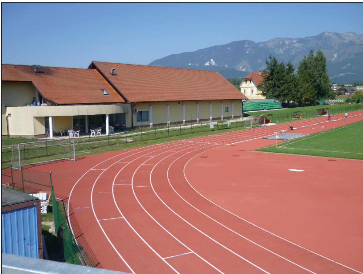
Prenovljeni Stadion prijateljstva v Mekinjah (Foto: arhiv Občine Kamnik)
