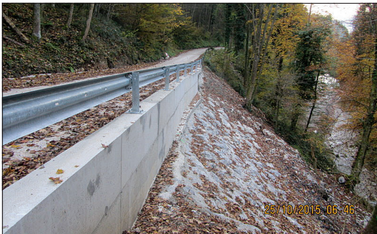
Sanacija zemeljskega plazu na cesti Snovik–Bela Peč (Foto: arhiv Občine Kamnik)
