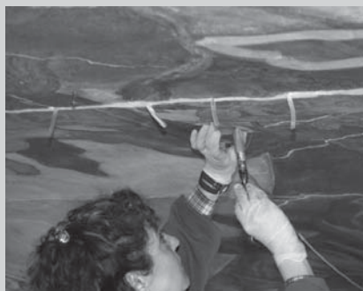
□ Slika 5. Sanacija razpok na temenu oboka
