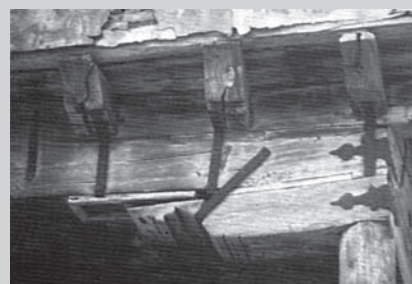
□ Slika 3. Ojačitev stropnih leg s kovinskimi sponami
