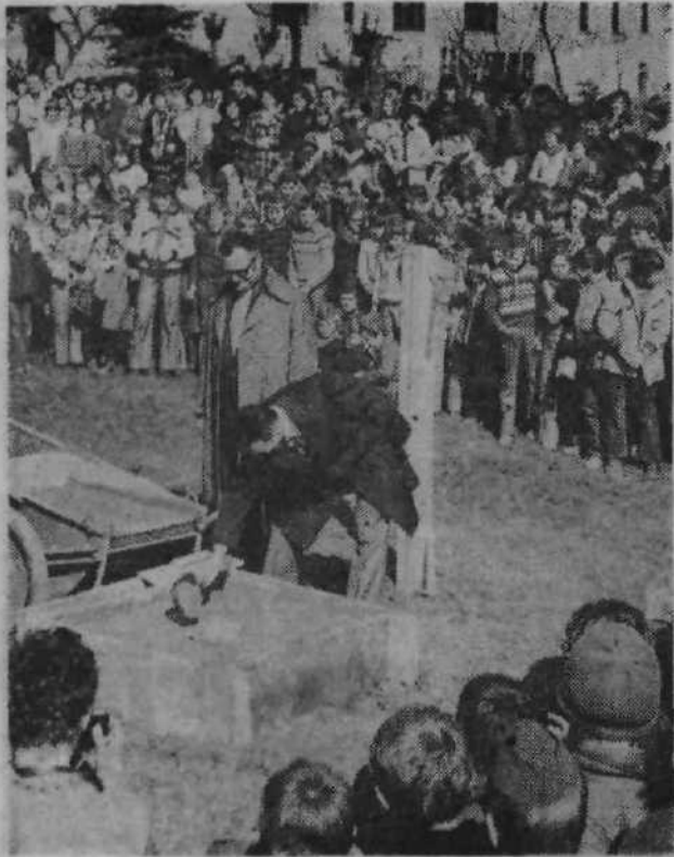
Na Crnučah je bilo nadvse slovesno ob začetku gradnje nove osnovne šole. Temeljni kamen je vzdal predsednik občinske skupščine Janez Rigler. Foto: ZLATKO DENISA
