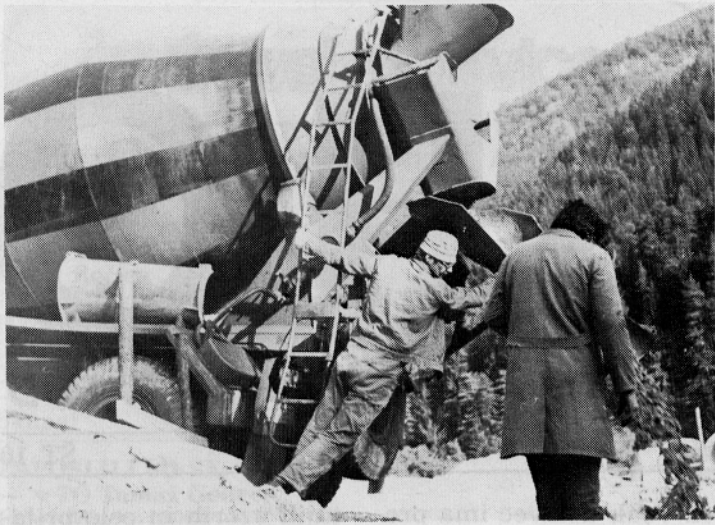
Takole poteka gradnja lakirnice v Mojstrani
