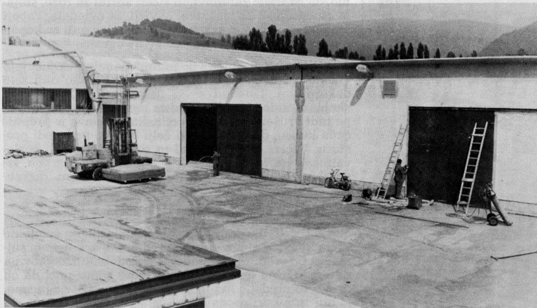
Nova proizvodna hala — furnirnica v TO Rečica je z vsemi potrebnimi stranskimi prostori in inštalacijami v zaključni fazi.
