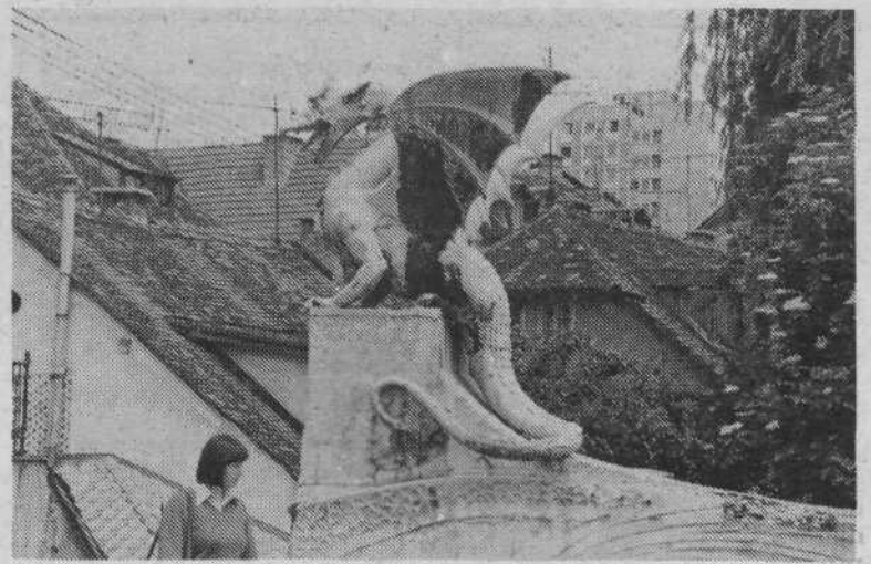
Zmajski most ni samo »zmajski«. Gre za pomembno prometno žilo, ki povezuje severni del mesta z južnim. Prek mostu poteka vsaj za zdaj tudi težki tovorni promet. Zaradi tega je nadvse pomembno, da je most trden in da ima ustrezno nosilnost.
