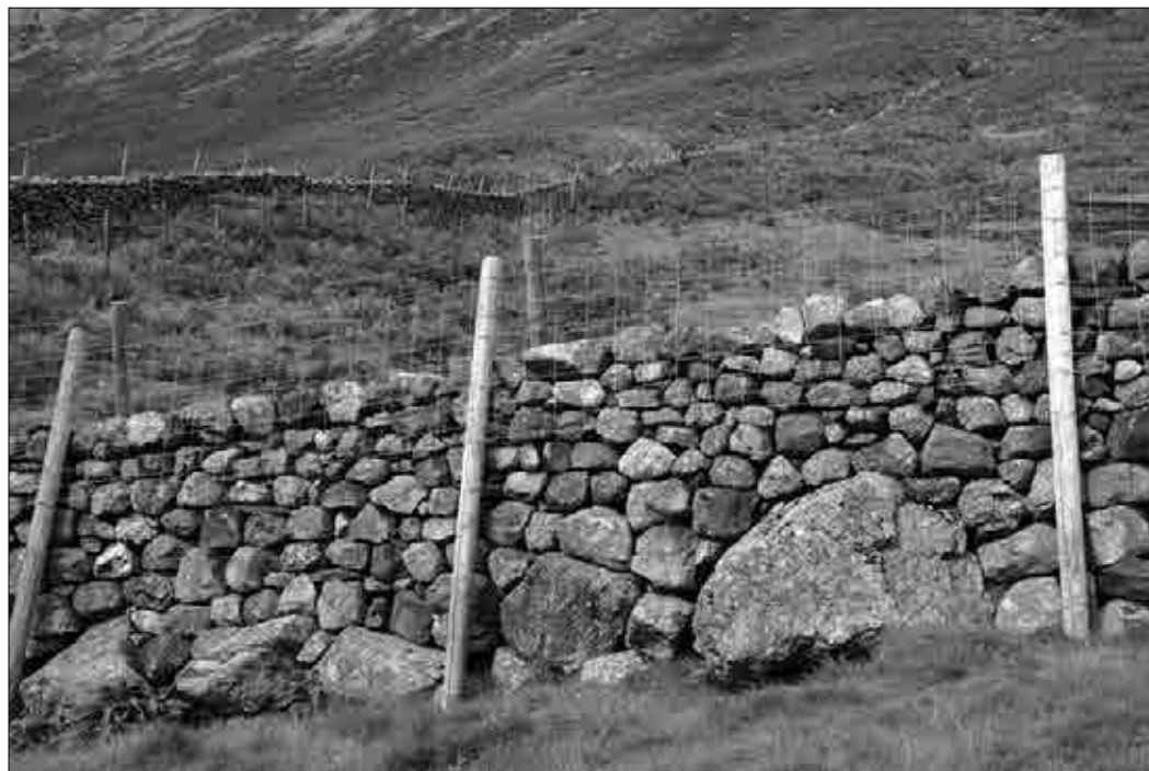
Slika 8. Ograda pašnika. Ambleside, Škotska. Primer dvojnega zidu, ki je utrjen z lesenimi koli. Leseni koli so bili postavljeni naknadno; lice zidu je ravno in nima žlebov za umeščanje lesenih kolov. Na fotografiji je dobro vidna tektonska tvorba zidu: ob peti (stik zidu s tlemi) so veliki balvani, ki so obloženi s kamni srednje velikosti. Proti vrhu se velikost kamnov zmanjšuje. Zaključna pokrivna vrhnja plast je sestavljena iz večjih enovito debelih kamnov (foto: Domen Zupančič).
