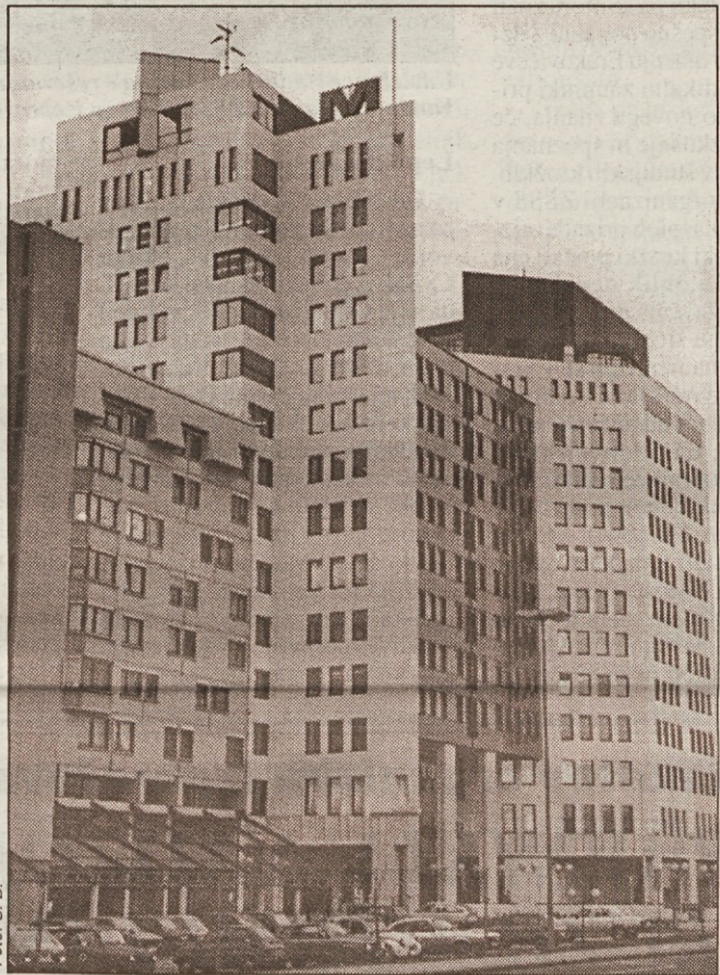
KAJ JE ZADAJ? - Mogočno pročelje Mercatorjeve poslovne zgradbe navzven še vedno dokazuje moč in trdnost...
