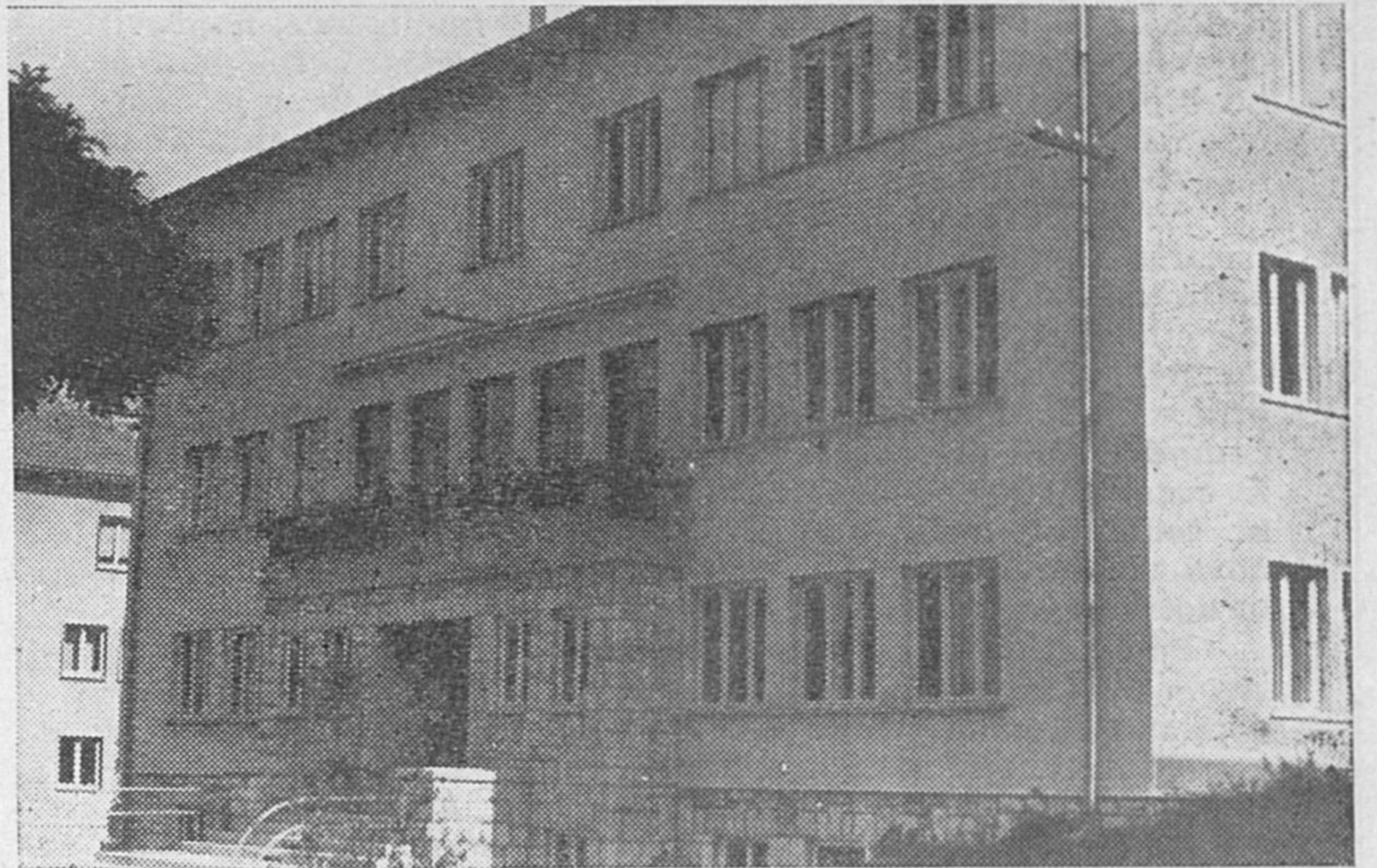
Upravno stanovanjska stavba Gozdnega gospodarstva v Postojni Foto Urbas
