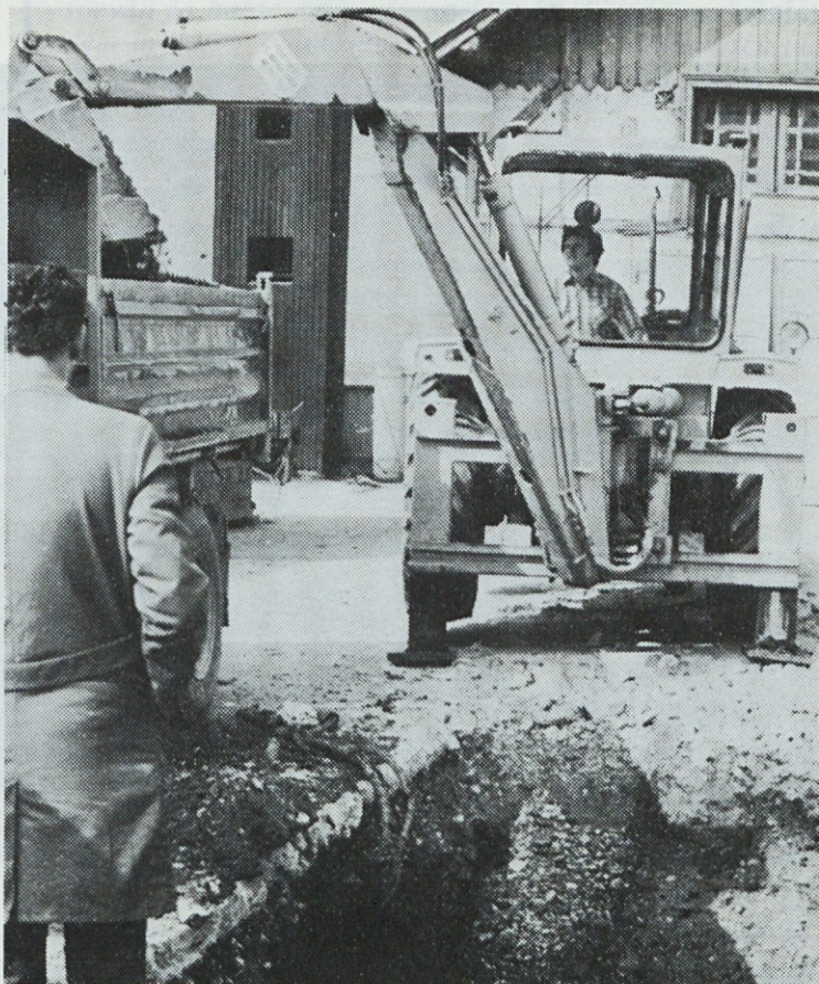
Izkop gradbene jame za betonski stolp, za vsis in izpuh zraka iz strojnice klimatskih naprav, ki bodo služile predilnici z brezvretenskimi stroji.
