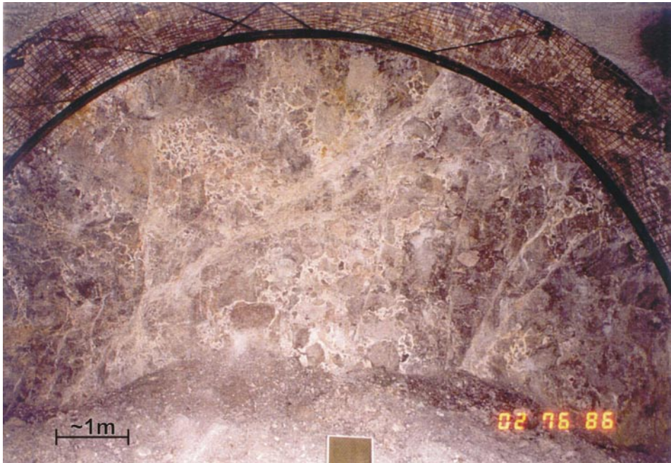
Slika 4. Sedimentna karbonatna breča, kalota na stacionaži 27+686 Picture 4. Sedimentary carbonate breccia, head at chainage 27+686
