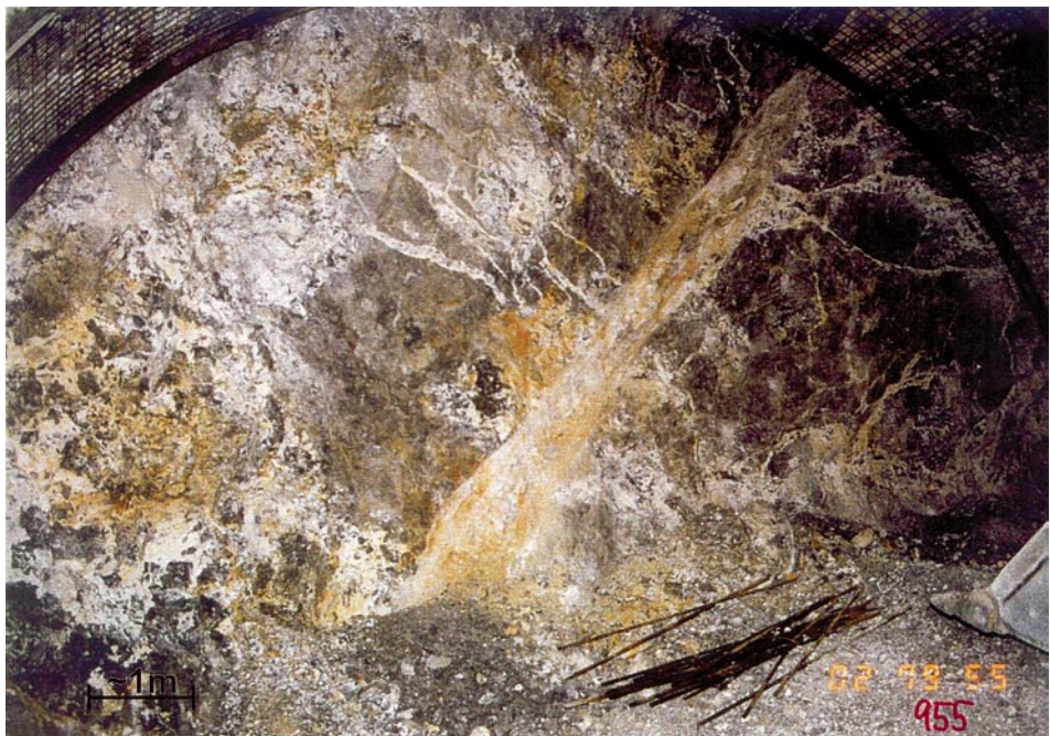
Slika 5. Tektonska breča, kalota na stacionaži 27+955 Picture 5. Tectonic breccia, head at chainage 27+955
