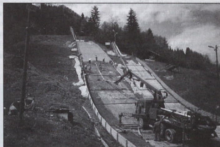
Delo na skakalnici- betoniranje
