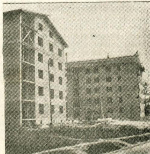
Dva stanovanjska stolpčiča na Kamniški cesti sta že pod streho
