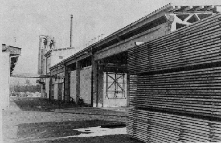
Kotlovnica in sušilnica v TO Podnart, zgrajena konec leta 1985
