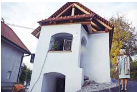
172. Obnovljena kašča in njena lastnica Anka Grom.
