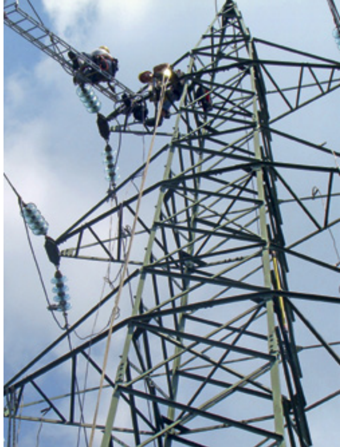
Prenapenjanje vodnikov na 20 kV daljnovodu Elektra Ljubljana.
