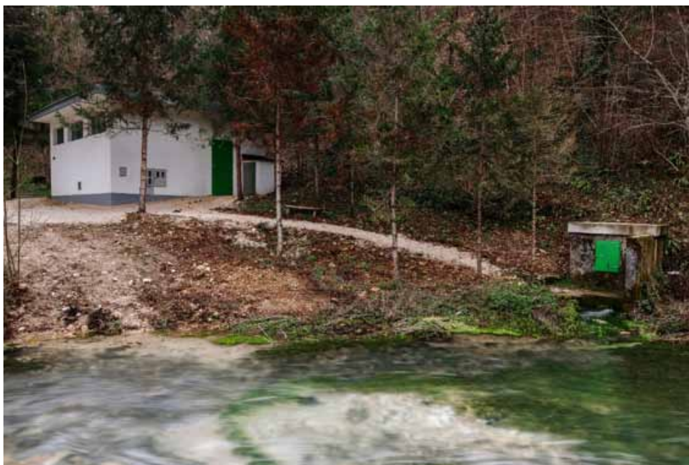
Slika 2: Fotografija zajetja ter objekta za pripravo in prečrpavanje pitne vode Jama Vir: Interno gradivo podjetja Kostak, d. d.
