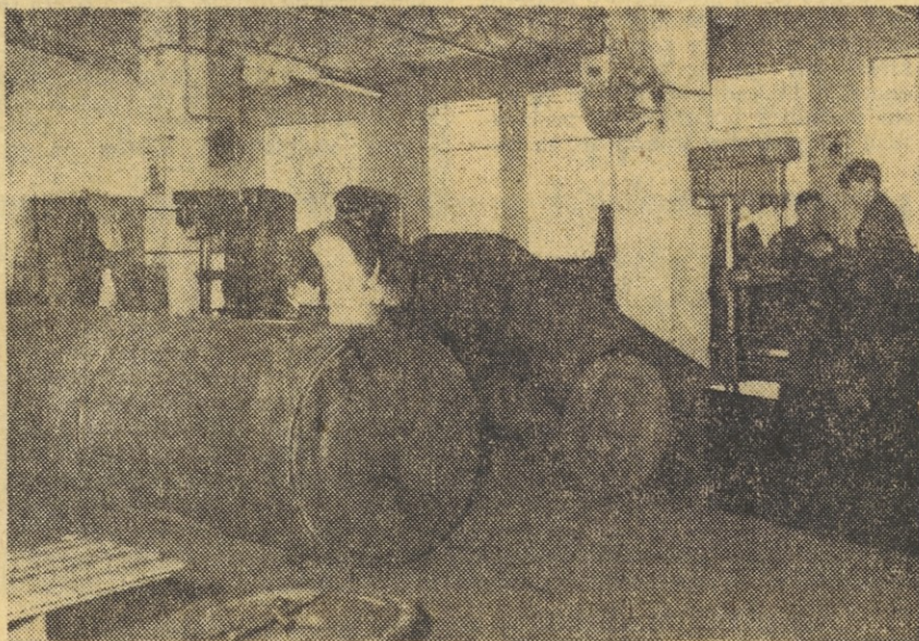
»CEVOVOD MARIBOR« — priprava artiklov za montažo
