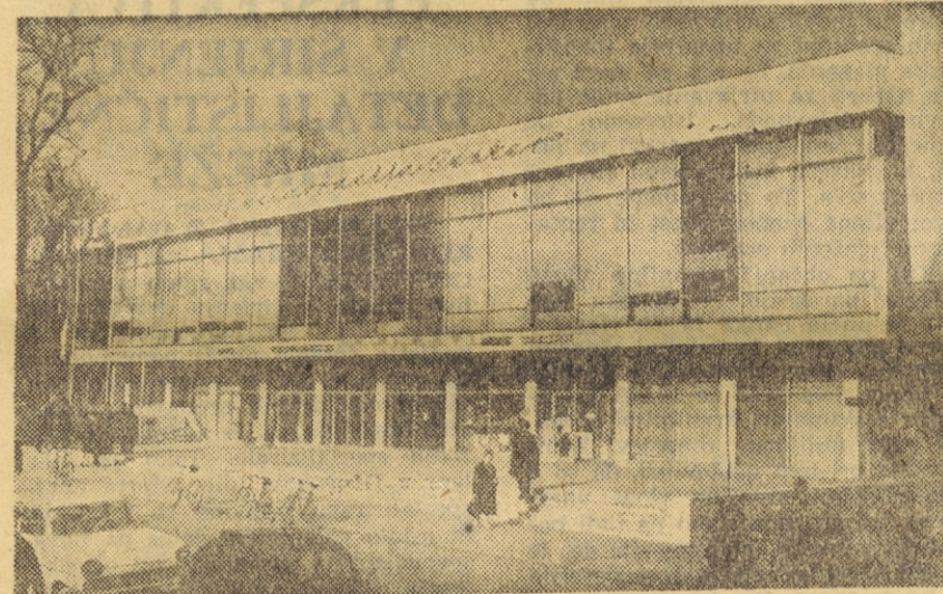
Pogled na novozgrajeno restavracijo »CENTER« Maribor
