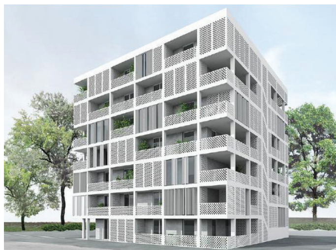
Slika 17 • Zunanost večetažnega stanovanjskega bloka po celoviti prenovi.
