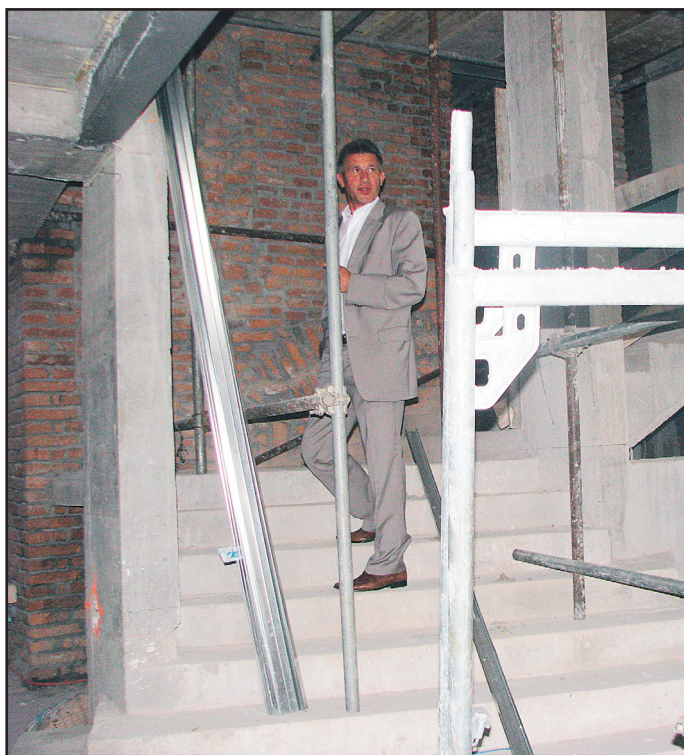
Pogled na prostorno stopnišče, kjer že lahko opazite, kako si staro podaja roko z novim. Stare opeke bodo ostale vidne, saj v mestu nimamo prav veliko zgodovinskih stavb, zato je arhitekt Rok Poles združil staro in novo.
