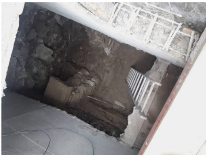
Slika 14 • Pogled navzgor na arkade in izvedene varovalne konstrukcije iz izkopnega prostora in pogled na dno izkopa vzhodne podzemne povezave.
