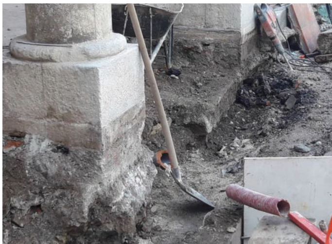
Slika 7 • Odkop temeljnih nastavkov arkadnih stebrov za izvedbo varovalnih konstrukcij.
