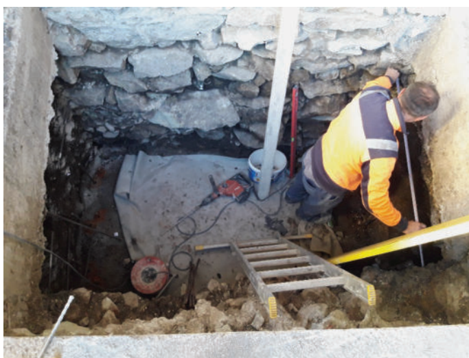
Slika 9 • Območje izkopa globljih vertikalnih kampad podzemnih povezav.
