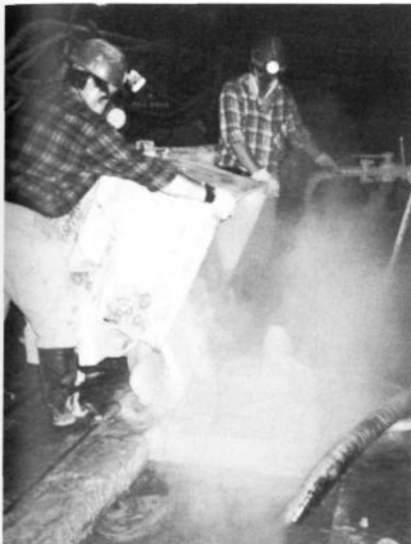
SLIKA 3: IZVRTANJE MEŠANICE CEMENTA IN KAMENE MOKE V BAZEN MEŠALNE POSTAJE NA VII. OBZORJU (FOTO: B. REŽUN, 1996).
