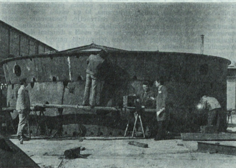
Izdelava zvarjenca za oblogo turbinskega jaška za Srednjo Dravo II
