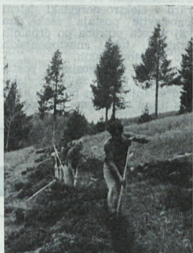
Pri kopanju jarka za vodovod
