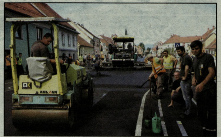
Asfaltiranje mestnega jedra
