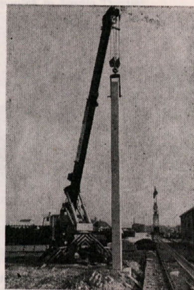
Postavljanje prvega stebra za novo halo v TOZD IGM Medlog
