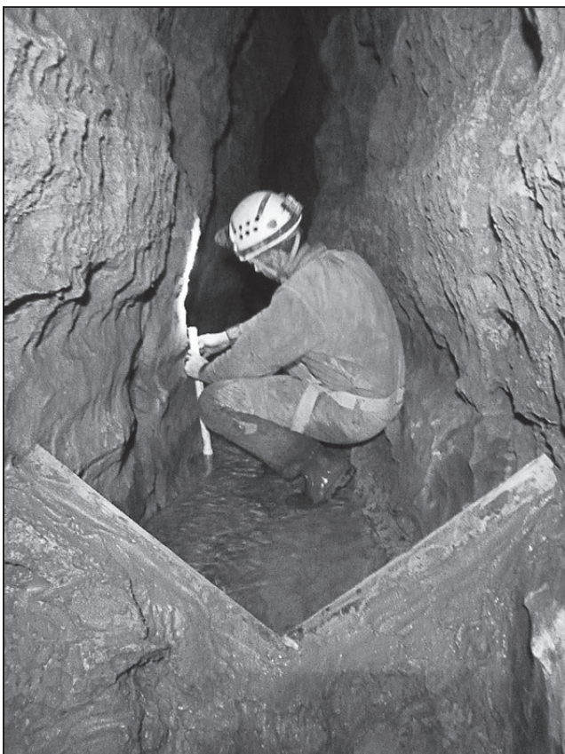
Prvi zgrajen preliv in inštalacija instrumentov (Omega, 2014; foto: Katarina Kosič Ficco).
