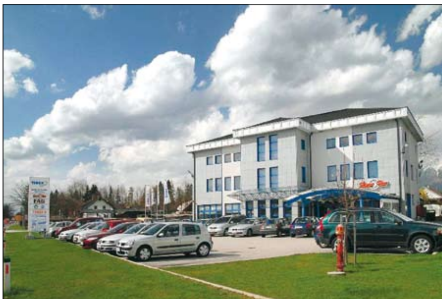
Poslovna zgradba podjetja Tinex
