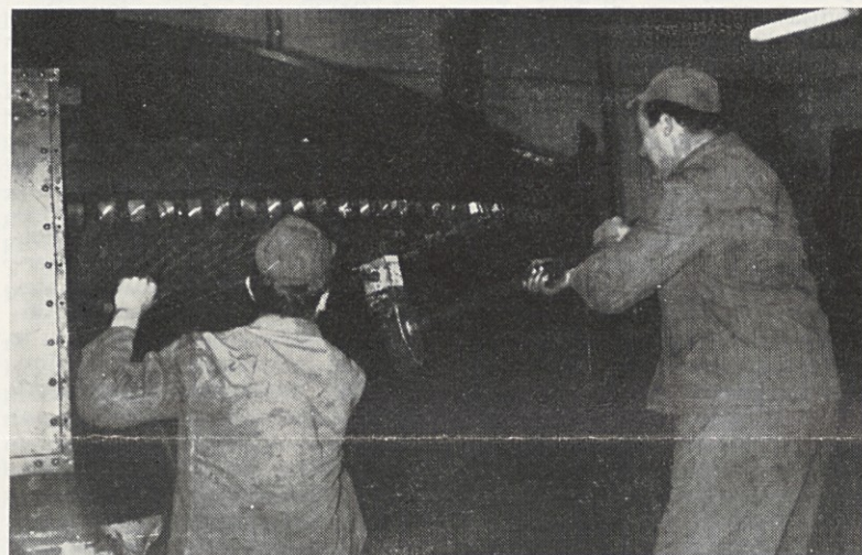
Popravilo lesenih zob pri turbini na Fužinah — Prava redkost, pa ne popravi, leseni zobje
