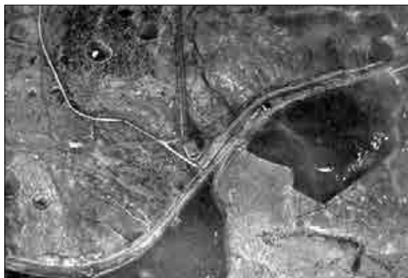
Rampa ob železniški progi. Prav preko te rampe so na lokacijo prispela letala in drug material za izgradnjo letališča (PANG, zbirka fotografij, t.e. 203. album 2).
