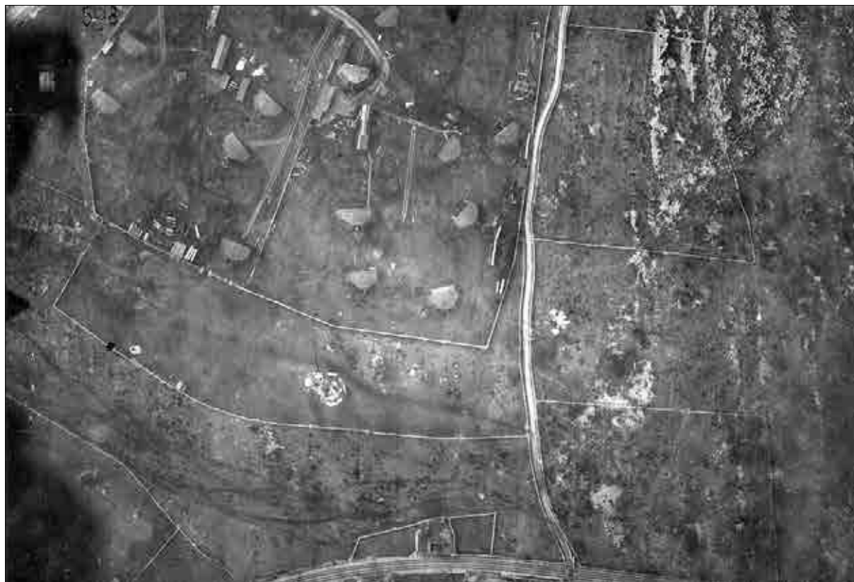
Leseni hangarji pri Proseku. Na fotografiji se jasno vidita železniška proga in valovit kraški teren. Zanimive so tudi različne stopnje gradbenih del na letalskih hangarjih (ÖStA/KA, LFT, Bildungssammlung, Flik 23, Karton 34, 598).
