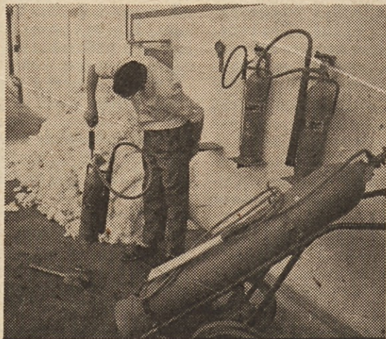
V nekaterih oddelkih je nevarnost požara zelo velika, zato imajo pripravljen kar cel 'arsenal' gasilnih naprav. Pri kontroli poklicni gasilec z ročno tehniko ugotavlja, če je aparat še vedno napolnjen.
