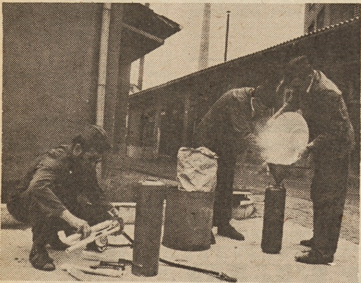
Po vsaki vaji oziroma gašenju morajo gasilne aparate spet napolniti. To delajo gasilci sami s posebnim prahom, ki ga uvažajo. Samo v obratu Melje imajo 1200 gasilnih aparatov
