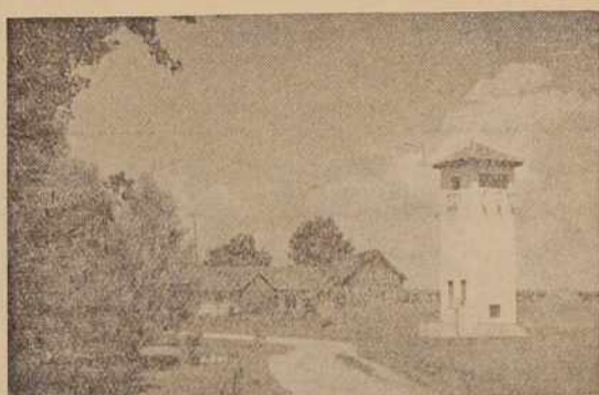
Transformator v Murskih Črncih
