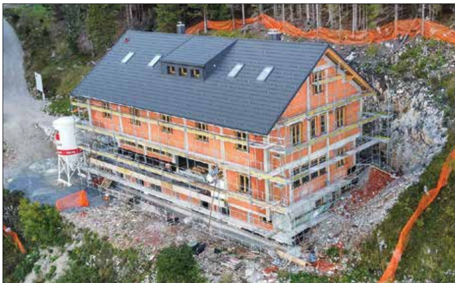
Nova Mozirska kočica je pod streho in zaprta, v kratkem sledi montaža centralne kurjave. (Foto: arhiv PD Mozirje)
