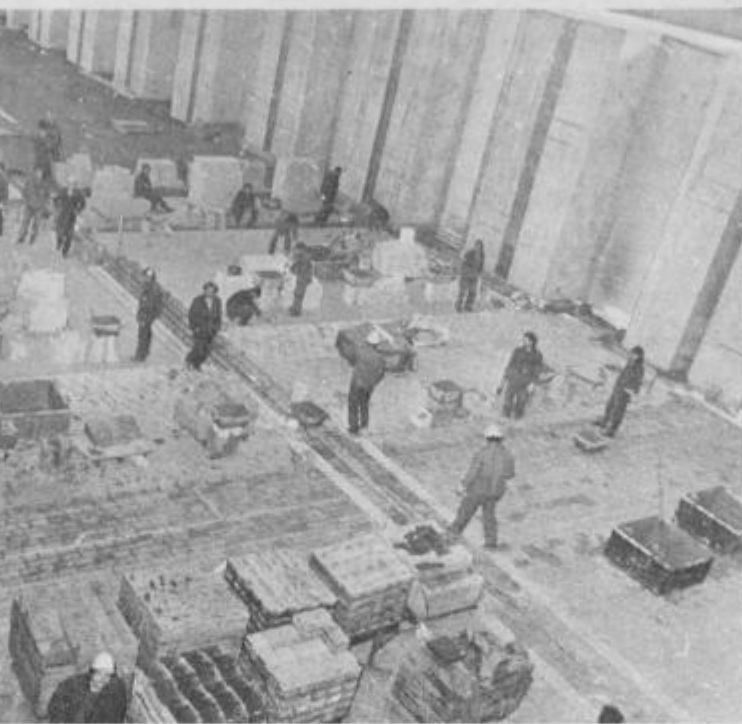
Poleg redno zaposlenih je v TGA trenutno še okoli 350 gradbenih in drugih delavcev. Na posnetku med polaganjem opeke v velikansko peč za pečenje anodnih blokov, v katero bodo vgradili prek 13 tisoč ton gradbenega materiala. (foto: M. Ozmeč)
