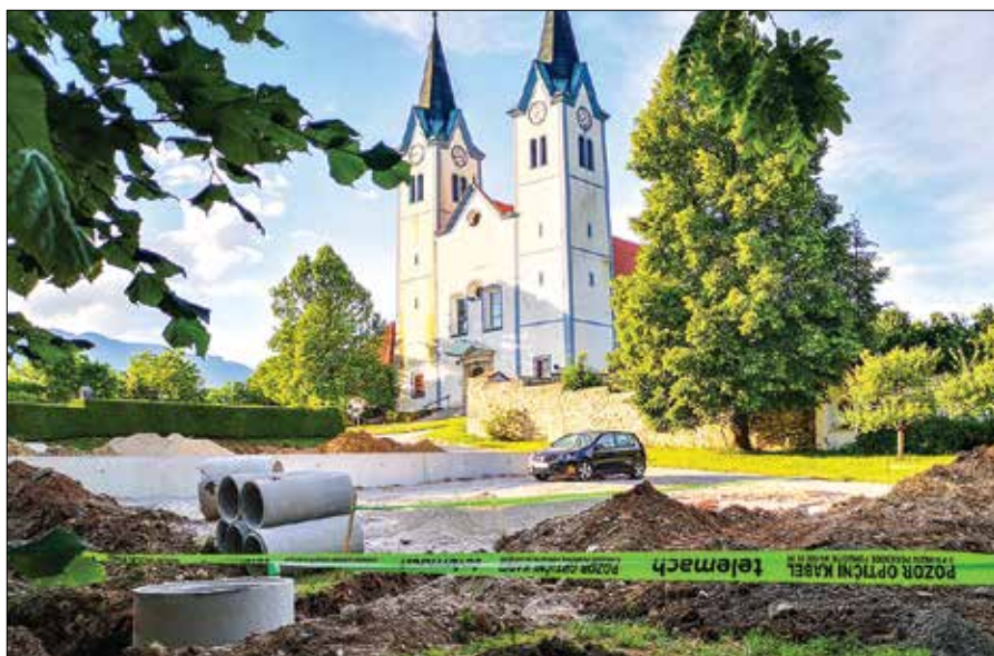
Obiskovalci bodo lahko dostopali do 30 parkirnih prostorov za osebna vozila, za osvetlitev bodo postavljene tri luči na sončno energijo.
