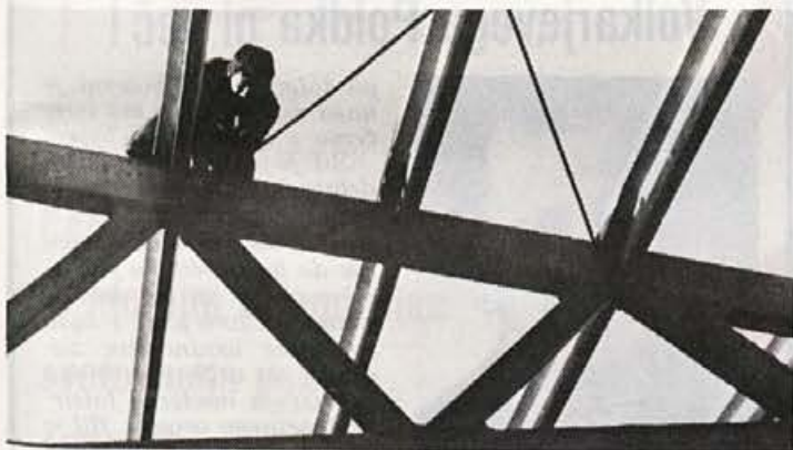
Montaža strešne konstrukcije na novi smučarski hali B 1
