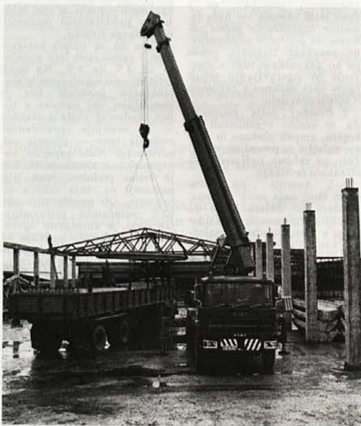
Najsodobnejši transport ostrešja na halo B 1
