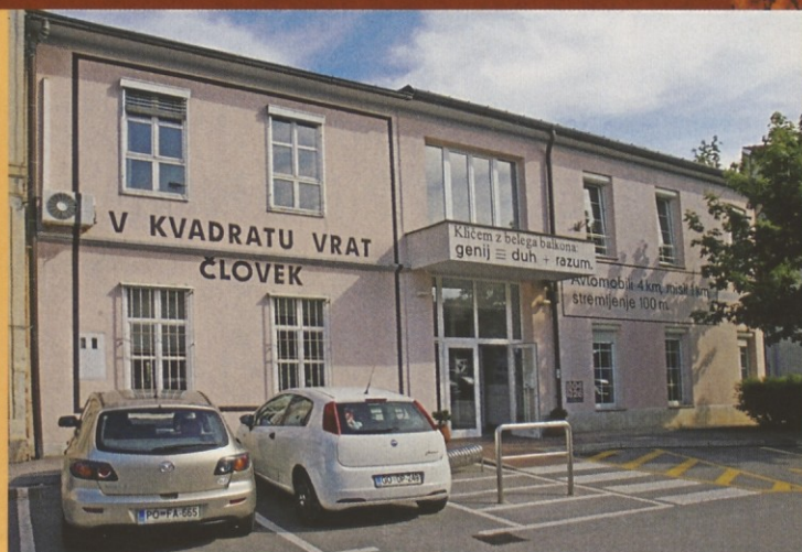
Pročelje Kosovelove knjižnice v Sežani.
