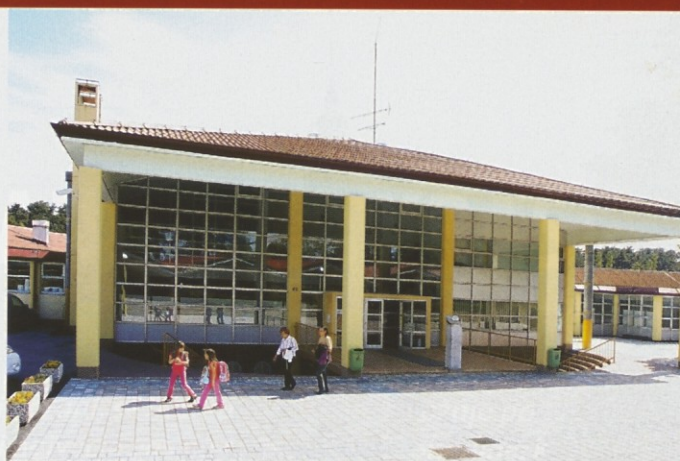
Nova šolska stavba v Dutovljah je bila zgrajena leta 1980.
