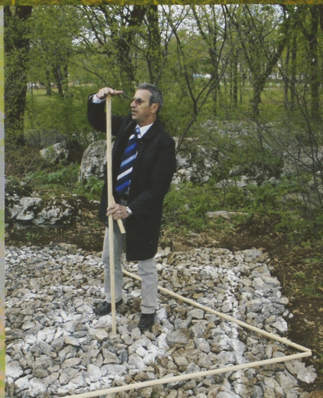
Slika levo: Na utrjeno podlago smo narisali predvideni tloris hiške. Pri risanju smo uporabili enakostranični trikotnik in njegovo višino. Človek je merilo arhitekture.
