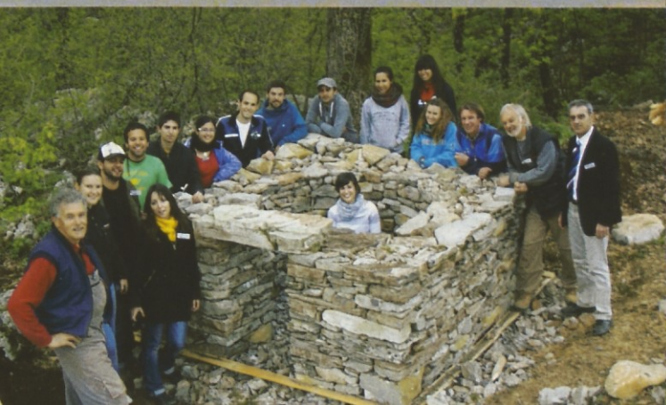
Delo prvega dne je bilo končano do višine 100 cm. Na fotografiji je zloženega več kot 7 ton kamna!
