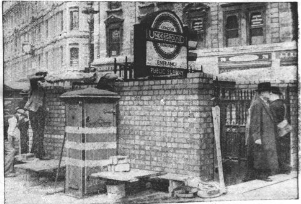
ZAKLONISČA V LONDONU. V angleški prestolnici ima vsaka hiša zaklonišče pred bombnimi napadi. Zaklonišča imajo tudi postajališča podzemne železnice
