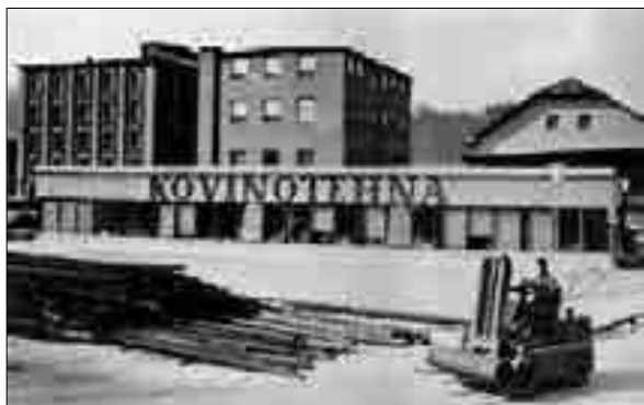
Poslopje nekdanjega mlina v sklopu Kovinotehninih skladišč (Muzej novejšje zgodovine Celje).
