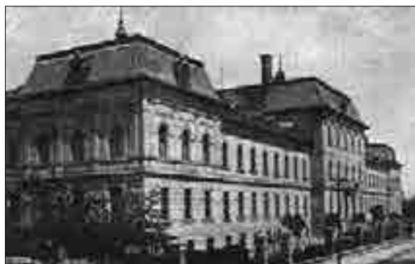
Poslopje državne bolnišnice za ženske bolezni v Ljubljani (Spominski zbornik Slovenije, str. 495).
