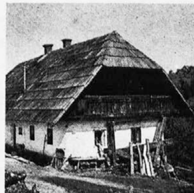
Značilna pohorska hiša. Zgrajena je iz kamna in lesa, pokrita pa s slamo ali skodlami. Okna so majhna, zato je v njej pozimi toplo, poleti pa hladno.
