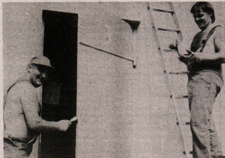
OBNOVA TRNASFORMATORJEV — Sevniški elektrikarji načrtno obnavljajo transformatorje. Nedavno so lično obnovili enega najstarejših transformatorjev pri Žagi, pretekli teden pa so se lotili obnove transformatorske postaje v sevniškem drevodu, od koder se napaja dobršen del starega mestnega jedra pa vse do Petrlove črpalke. Ta transformator je lani za več kot poldrugi meter poplavila ob katastrofalni poplavi Sava, zato so morali delavci Elektra, še predno so vzeli v roke čopiče in barvo, postoriti vrsto drugih vzdrževalnih del.
