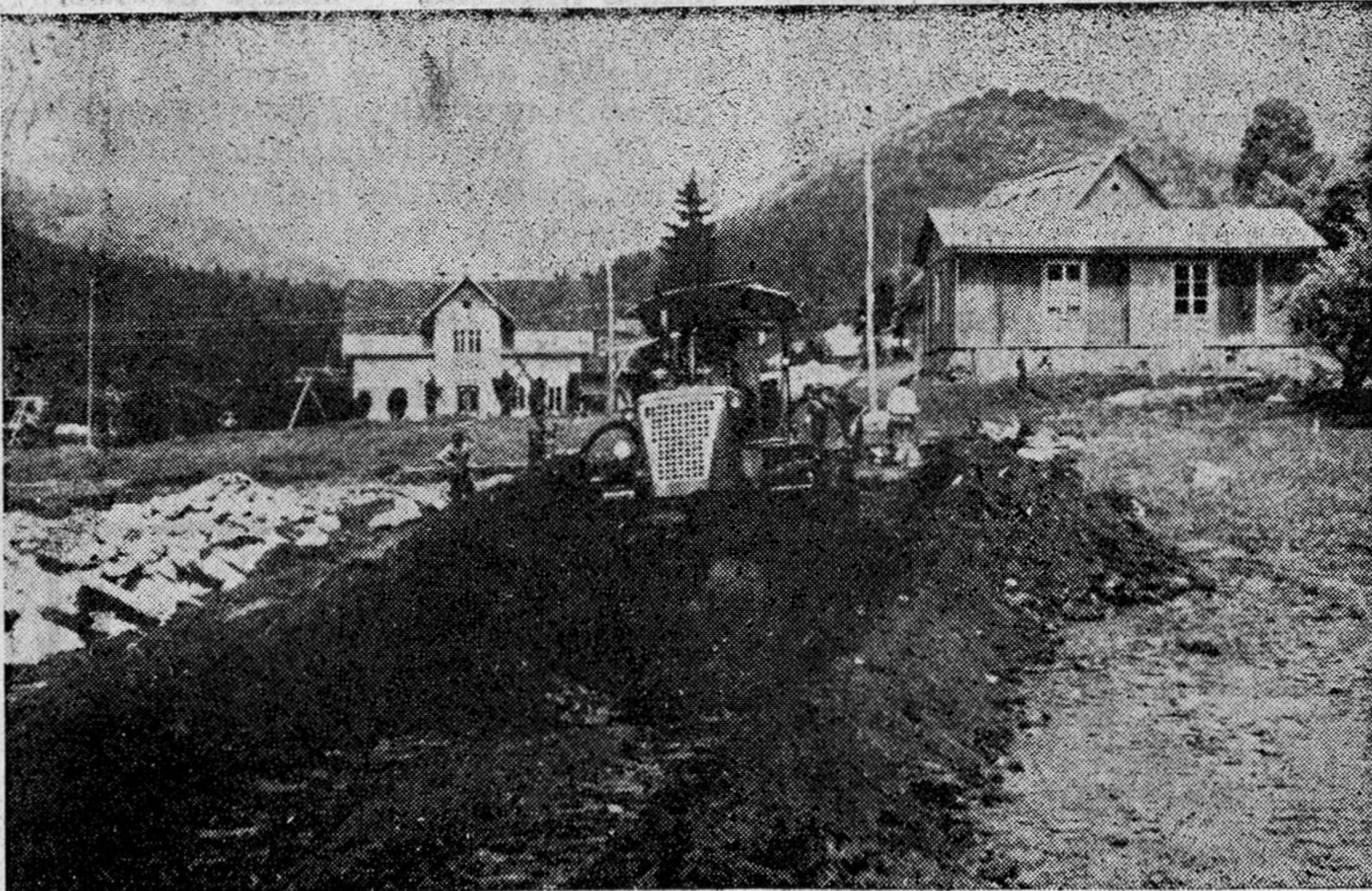
Za hiter odkop zemlje je podjetje najelo buldožer, ki pridno odstranjuje vrhno plast zemlje
