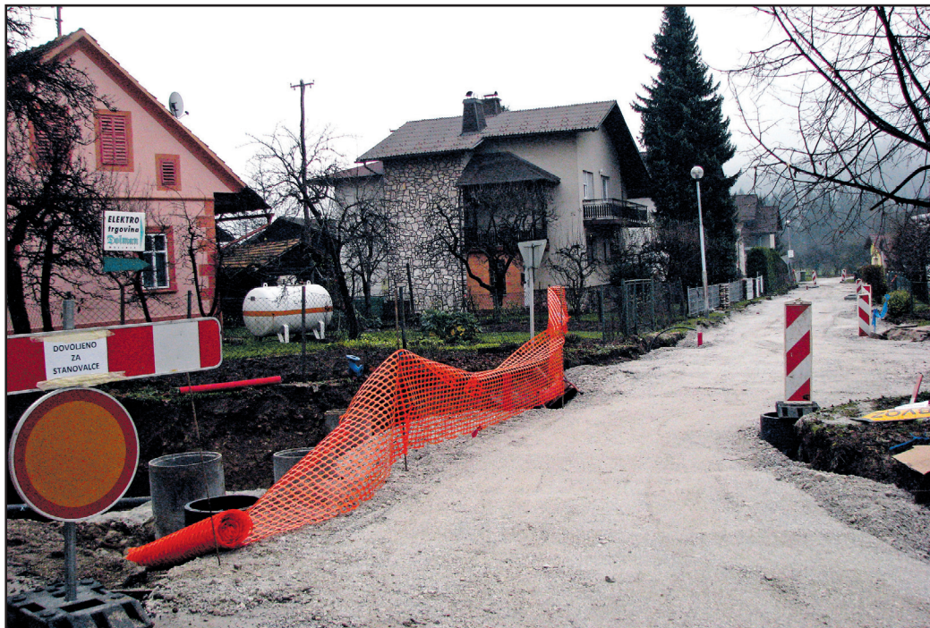
Na Hofbauerjevi ulici v Mozirju bodo obnovili vse, kar je v zemlji, tam, kje bo mogoče, bodo zgradili tudi pločnike.
