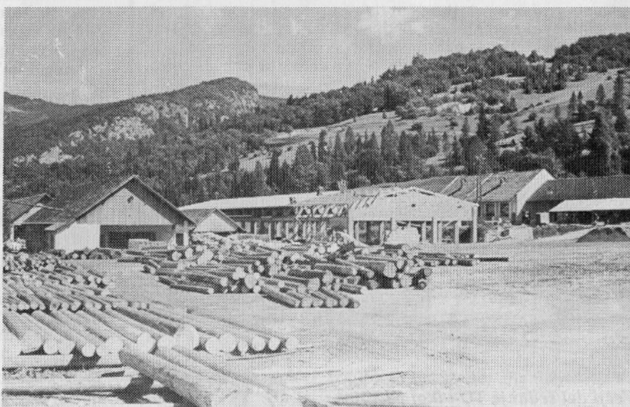
Gradnja hale za proizvodnjo opažnih plošč
