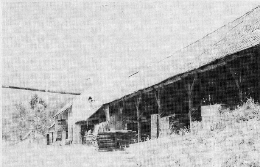
V zgornjem objektu je tekla proizvodnja lesne volne in lesnih vrvi, kasneje so prostori služili mizarški delavnici, nato lakirnici, danes pa je objekt preurejen v skladišče vnetljivih snovi
