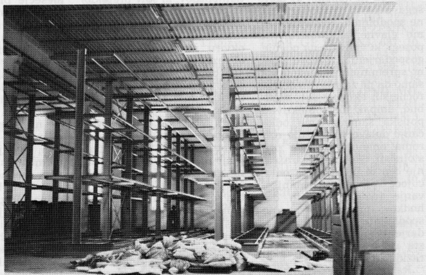
Skladišče gotovih izdelkov — montaža regalov
