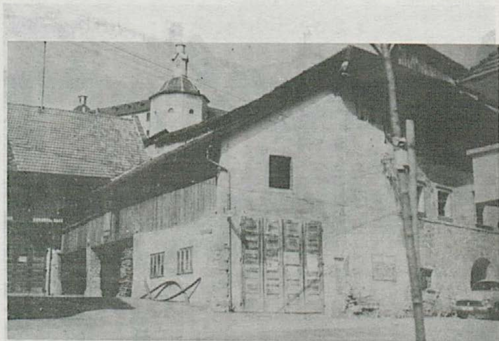
Martinova garaža ob mestnem obzidju pred občino, desno stara Martinova hiša, levo podrta Martinova hiša ob obzidju, sedaj prostor pred Miholom (Original Martin Eržen, foto Šturm).
