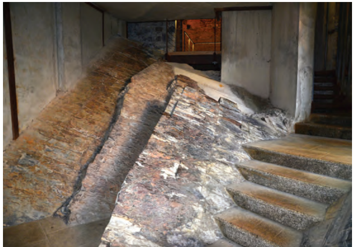
Plasti zgornjekarbonskega skrilavega glinavca na zgornji postaji vzpenjače na Ljubljanski grad. Foto: Matevž Novak.
