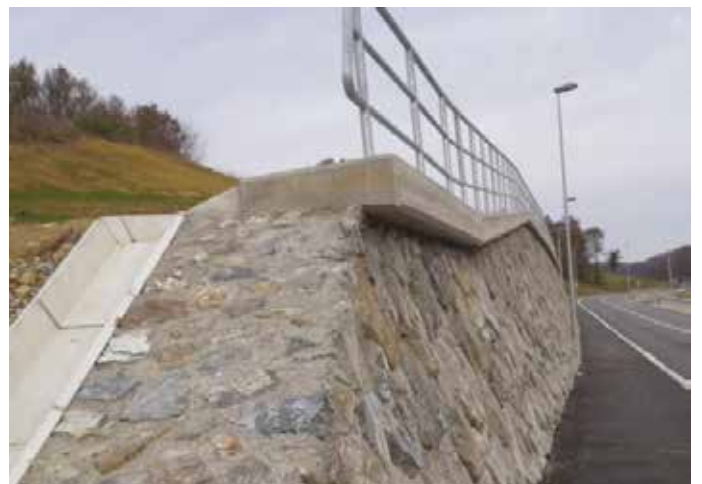
Slika 18 • Fotografija robnega venca z večjim previsom.
