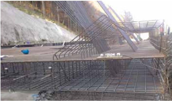
Slika 13 • Prikaz t. i. plavajočih armaturnih palic.
