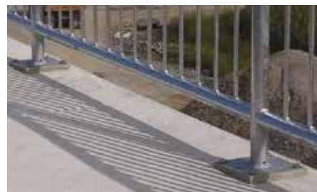
Slika 29 • Ustrezni detajli pritrjevanja po podlivanju.
