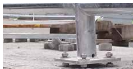
Slika 28 • Ustrezni detajli pritrjevanja pred podlivanjem.
