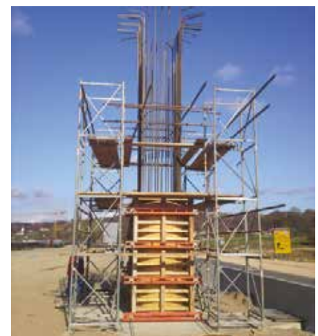
Slika 34 • Oder za podpiranje armature.
