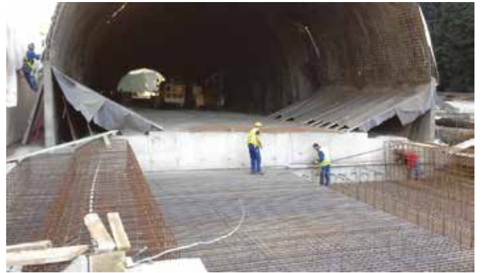
Slika 14 • Prikaz prve in druge faze betonskega preza talne plošče portala predora.
