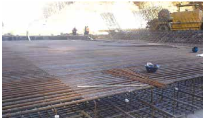
Slika 12 • 100-% preklop armature v območju največjega upogibnega momenta.
