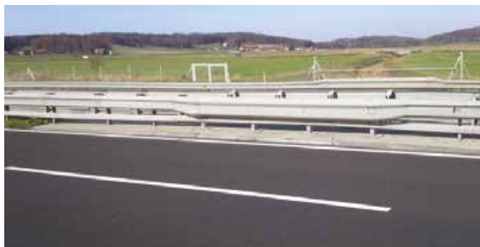
Slika 20 • Odbojna ograja na propustu pod AC.
