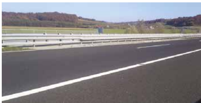
Slika 21 • Odbojna ograja na manjšem mostu na AC.
