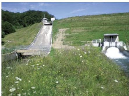
Slika 14 • Izpust iz Klivnika, 6. 8. 2008. ob 8 00 , pri pretoku Reke 2,08 m 3 /s, izpust vode ni bil potreben
