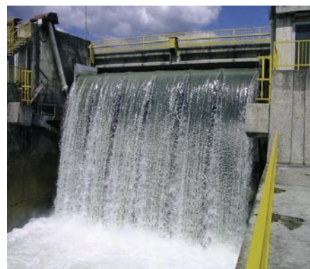
Slika 8 • Jez na Dravi z odvodnim kanalom proti HE
