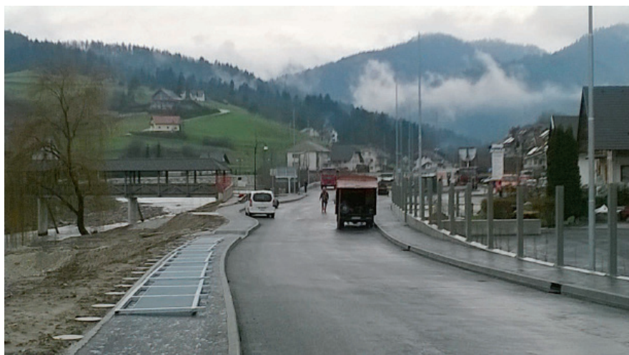
Gradnja gorenjevaške obvoznice, december 2014. (foto: Damjana Peternelj)
