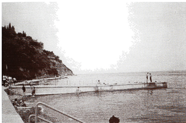
Lani na novo zgrajeni betonski pomol v Fiesi. Bralci naj sami presodijo, ali ima pisec pisma Portorožanu prav...
