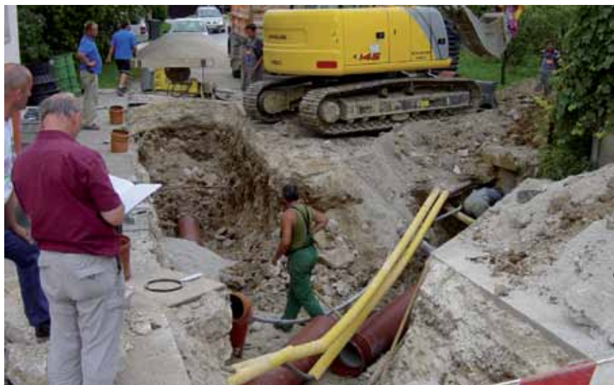
Vse kaže, da bo občini jeseni le uspelo dobiti kohezijska sredstva za gradnjo čistilne naprave Logatec in kanalizacije, tako da bo v prihodnjih letih podobne prizore videti na Martinj hribu in Kalcah, pozneje pa tudi v Rovtah, Grčarevcu in Lazah. (foto: arhiv KP Logatec)
